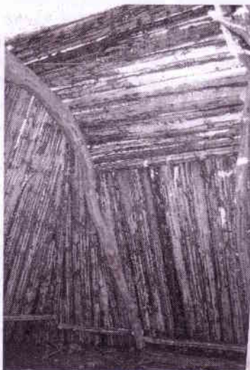
Hamsungamme: Gammens innervegg består av rundstokker lagt på reisverket. På yttersiden stables det torv på hverandre for iso-lering. Musen "Madame" var tilstede da bildet ble tatt.
